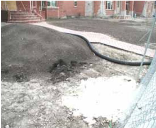
Illustration 2-5. Sites de construction avec ciment (gauche) et roches concassées (droite) sur le point d'être recouverts de sol, créant ainsi une barrière à l'action capillaire. Photos courtoisie de Dan Dinelli.
