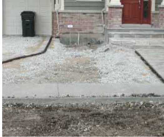
Illustration 2-5. Sites de construction avec ciment (gauche) et roches concassées (droite) sur le point d'être recouverts de sol, créant ainsi une barrière à l'action capillaire. Photos courtoisie de Dan Dinelli.
